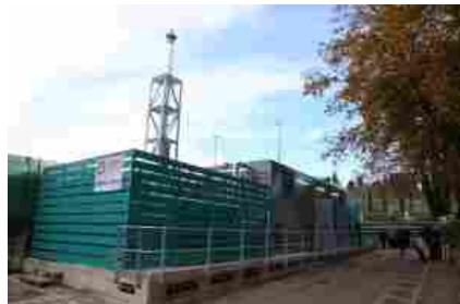
Il nuovo sistema di trigenerazione, fornito e installato da Centrica Business Solutions, partner tecnico di **Camst** group, ha una potenza elettrica pari a 531 kWe e consente di produrre simultaneamente energia elettrica, termica e frigorifera, attraverso un'unica soluzione ad alta efficienza, con un significativo miglioramento delle performance energetiche del Campus e un importante contributo alla riduzione dei consumi, dei costi di esercizio e delle emissioni climalteranti.
