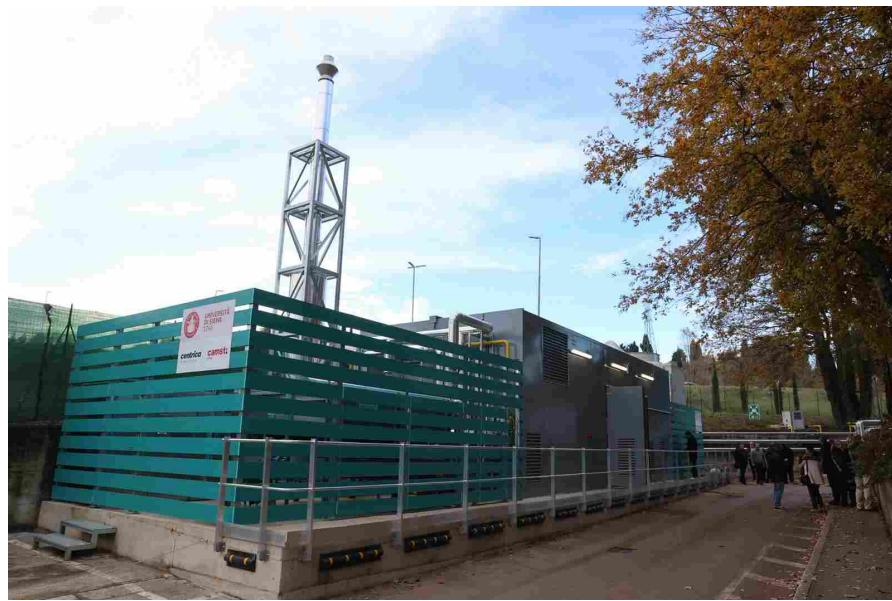
La tecnologia installata consente di utilizzare l'energia elettrica prodotta direttamente dalle utenze interne, mentre l'energia termica, recuperata dai circuiti del cogeneratore, alimenta le caldaie esistenti e il gruppo frigorifero ad assorbimento. Parte di quest'ultima è utilizzata per generare energia frigorifera
